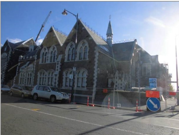
図3、修復工事中のアートセンター
