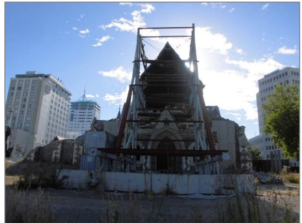
図4、修復工事中の大聖堂
